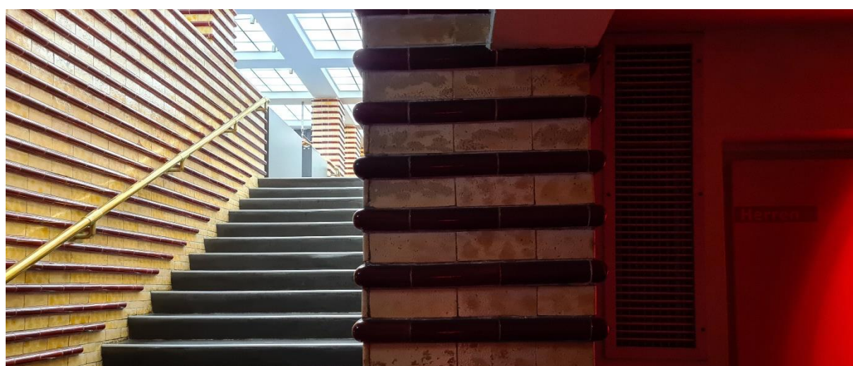
Abbildung 2: Zuluft Versorgung im Eingangsbereich Rabenhof Theater
