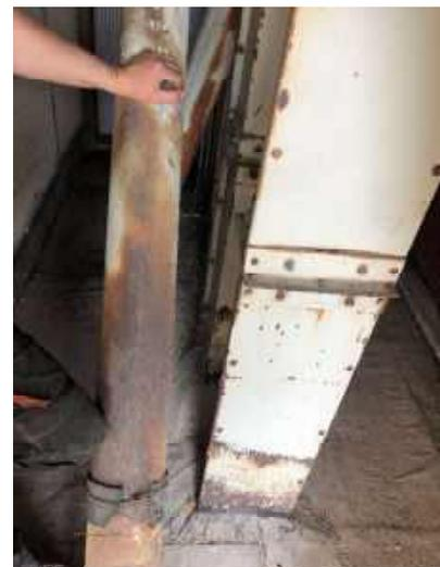
Abbildung 13 Rohre zur Führung der AC-Kabel ins Gebäude innere im Anbau
