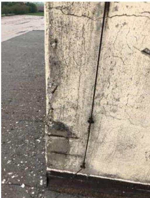
Abbildung 6 Betonaufplatzungen Kante Süd zu Ostfassade inkl. Blitzschutz
