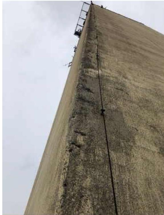
Abbildung 5 Betonaufplatzungen Kante Süd zu Ostfassade inkl. Blitzschutz
