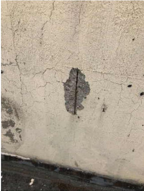
Abbildung 4 Betonaufplatzung Südfassade
