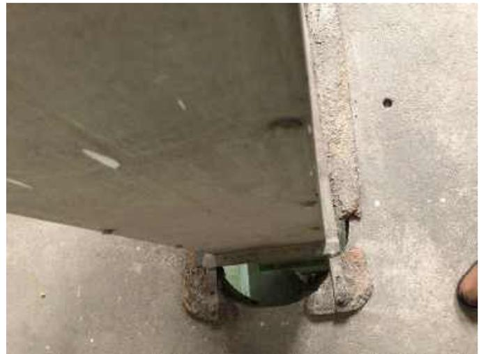
Abbildung 15 Fortlaufender Kabelweg mit bestehenden Kernbohrungen in das Erdgeschoß
