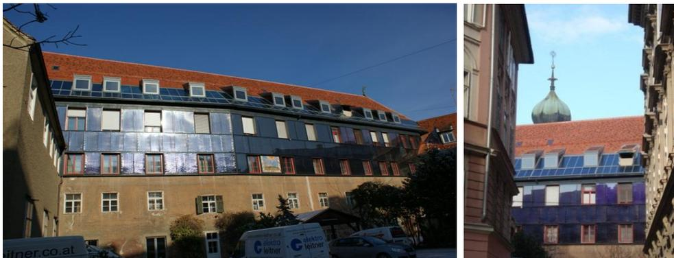
Abbildung 269: Ansicht des 210 m<sup>2</sup> umfassenden Kollektorfelds am Dach und der Fassade des "Franziskanerklosters Graz", Bildquelle: AEE INTEC
