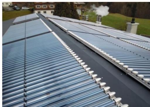
Abbildung 84: Ansicht des Gebäudes „Fernwärme Düringer“ (links) auf dessen Dach die beiden nach Süd-Ost bzw. Nord-West orientierten Röhrenkollektorfelder montiert sind (rechts)
