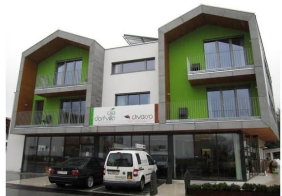
Abbildung 69: Ansicht des Gebäudes „Dorfvilla – alles anders“ mit Blick auf die in die Süddachflächen integrierten Kollektoren (links, Bildquelle: <http://www.diedorfvilla.at>) und der am Flachdach aufgeständerten Kollektoren am Verbindungsbau (rechts, Bildquelle: AIT)
