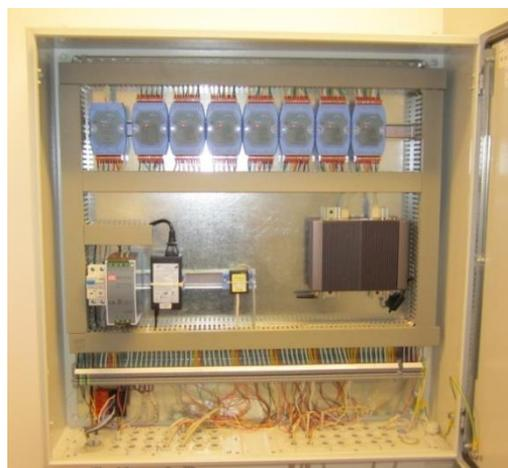
Abbildung 165: Linkes Bild: Kältespeicher (links), zwei Wärmepumpen (Mitte) und die Abgänge zu den Verbrauchern (rechts oben) der Anlage „Easy Life Schütz“. Rechtes Bild: Monitoring-Box mit Eingangsbaugruppen (oben) und Industrie-PC (rechts)
