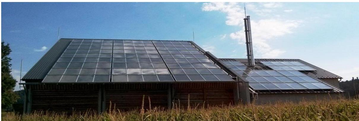
Abbildung 281: Ansicht des 350 m<sup>2</sup> großen Kollektorfeldes am Dach des Heizhauses bzw. Hackgutlagerraumes der Anlage „Nahwärme Großklein“, Bildquelle AEE INTEC
