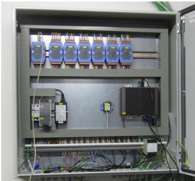
Abbildung 301: Monitoring Box mit Eingangsbaugruppen (oben) und Industrie-PC (rechts), Bildquelle: AIT
