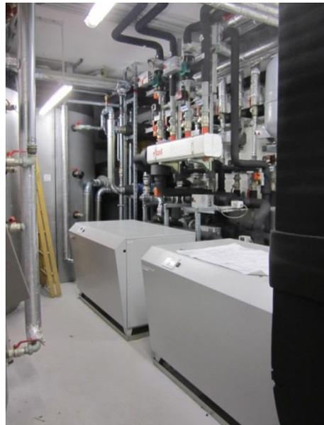
Abbildung 299: Linkes Bild: Ausdehnungsgefäß der Solaranlage (links) Solarsteuerung im Sekundärkreis mit Umwälzpumpe, drei Umschaltventilen und Abgänge zu den Energiespeichern (Mitte) sowie darüberliegender Solarwärmetauscher. Rechtes Bild: Beide Raumheizungspuffer (links außen), Wärmepumpen (unten) und darüberliegender Kälteverteiler im Technikraum, Bildquelle: AIT
