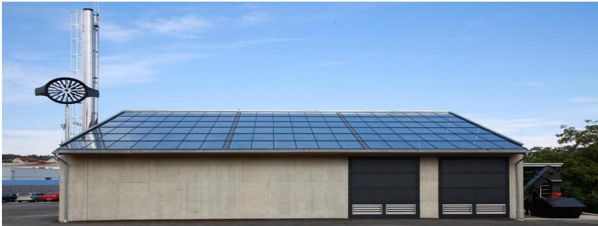
Abbildung 221: Ansicht des 250 m<sup>2</sup> großen Kollektorfeldes am Dach des Heizhauses der Anlage „Nahwärme Gleisdorf - Schillerstraße“, Bildquelle: Feistritzwerke STEWEAG GmbH
