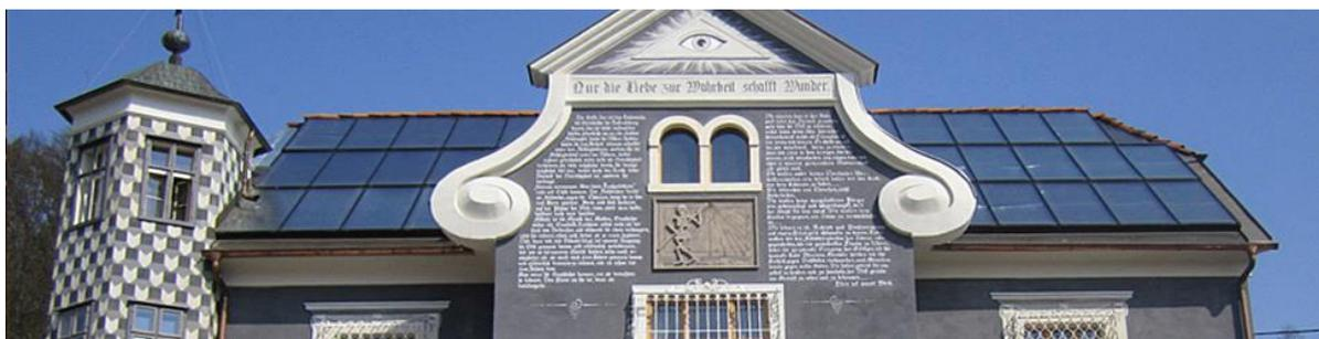
Abbildung 123: Ansicht des 70 m<sup>2</sup> umfassenden Kollektorfelds am Dach der Anlage „Hotel Metbräu“, Bildquelle: [www.steirischesprung.at](http://www.steirischesprung.at)
