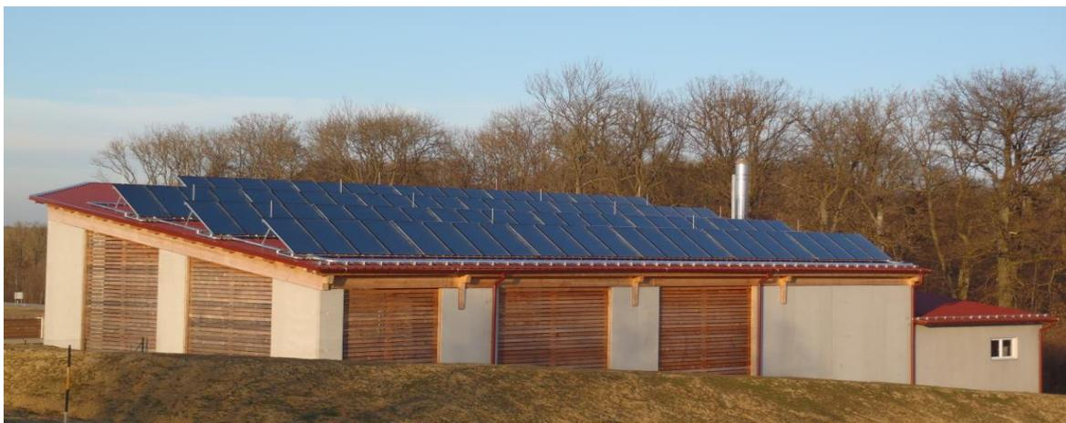
Abbildung 6: Ansicht des 250 m<sup>2</sup> umfassenden Kollektorfeldes am Dach des Hackgutlagerraumes der Anlage „Nahwärme Weichstetten“, Bildquelle: OÖ Gas-Wärme GmbH
