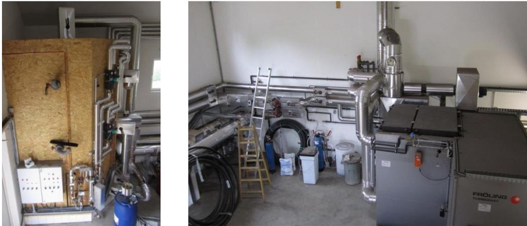
Abbildung 134: Linkes Bild: Pufferspeicher mit Schaltschrank für die Steuerung (unten links), Solarwärmetauscher (unten Mitte) mit Solarverrohrung (Mitte senkrecht und oben rechts) sowie Verrohrung für die Nachheizung und die Netzanbindung (Mitte rechts). Rechtes Bild: Hackgutkessel (rechts) sowie Verrohrung zum Pufferspeicher (links) und Anbindung zum Rauchfang (Mitte senkrecht), Bildquelle: AIT
