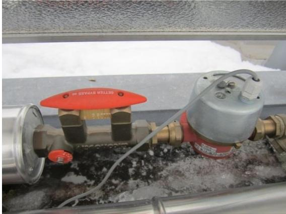
Abbildung 238: Abgleichventil und Durchflusszähler in der Zuleitung zum südlichsten Kollektorfeld
