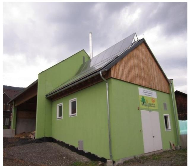
Abbildung 133: Ansicht des Gebäudes der Anlage „Nahwärme Kraubath“ mit Blick auf die Kollektoren am Hackgutlager (links) und am Dach des Heizraumes (rechts), Bildquelle: AIT
