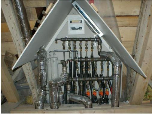
Abbildung 270: Ansicht der Rohranbindung des Kollektorfeldes im Dach (rechts), Bildquelle: AEE INTEC
