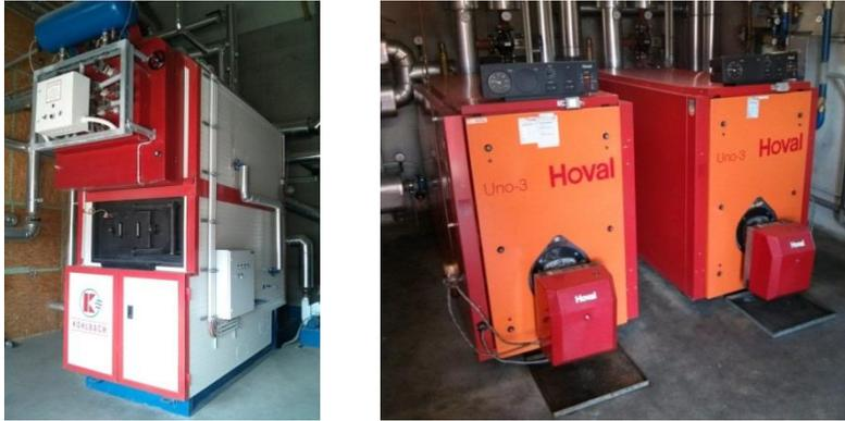
Abbildung 282: Ansicht des 600 kW Hackgutkessels sowie der beiden Ölkessel mit jeweils 200 kW der Anlage „Nahwärme Großklein“, Bildquelle AEE INTEC
