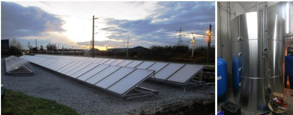
Abbildung 183: Ansicht des 324 m<sup>2</sup> großen Kollektorfelds der Anlage "Fixkraft Kraftfutter" (links, Bildquelle: Fixkraft-Futtermittel GmbH) sowie des 6 m<sup>3</sup> umfassenden Energiespeichers (rechts, Bildquelle: AEE INTEC)
