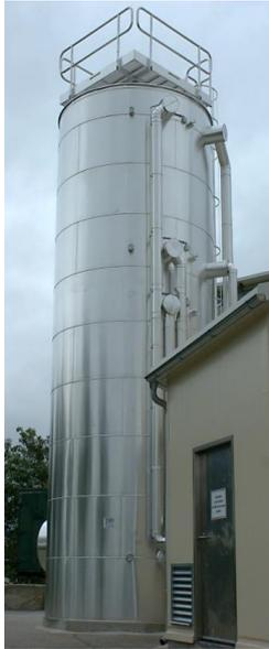
Abbildung 339: Ansicht des am Werksareal der Fa. Fleischwaren Berger befindlichen 60 m<sup>3</sup> Pufferspeichers (Bildquelle: SOLID)
