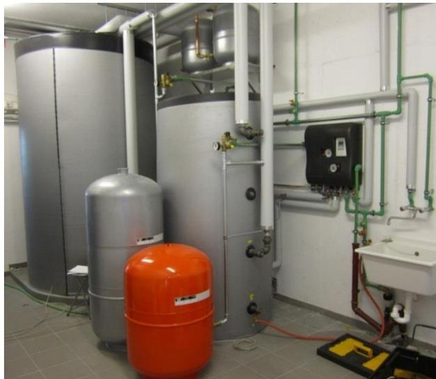
Abbildung 164: Linkes Bild: Solarsteuerung im Sekundärkreis mit drei Umschaltventilen und Abgänge zu den Energiespeichern (Mitte), Solarwärmetauscher (links oben) und Wärmetauscher zum Erdspeicher der Anlage „Easy Life Schütz“ (links unten). Rechtes Bild, v.l.n.r.: Heizungspuffer, zugehöriges Ausdehnungsgefäß, Ausdehnungsgefäß für Warmwasserspeicher, Warmwasserspeicher sowie zwei Ausdehnungsgefäße im Solarprimärkreis (oben) und Frischwassermodul (rechts)
