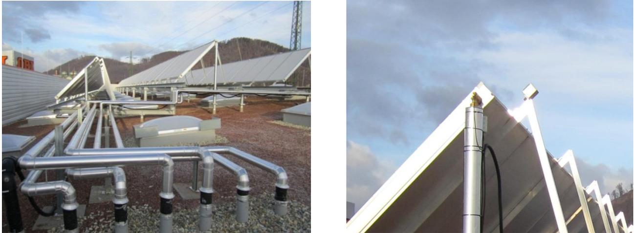
Abbildung 104: Linkes Bild: Seitenansicht der drei aufgeständerten Kollektorfelder sowie Leitungsführung durch die Gebäudedecke der Anlage „OBI Graz Nord“. Rechtes Bild: Detail Globalstrahlungssensor und Kollektortemperaturfühler am mittleren Kollektorfeld
