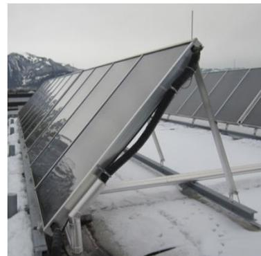
Abbildung 237: Ansicht des Gebäudes „ETG Sonnenhaus“ (links). Aufständigung und Anschluss der Kollektoren (rechts)
