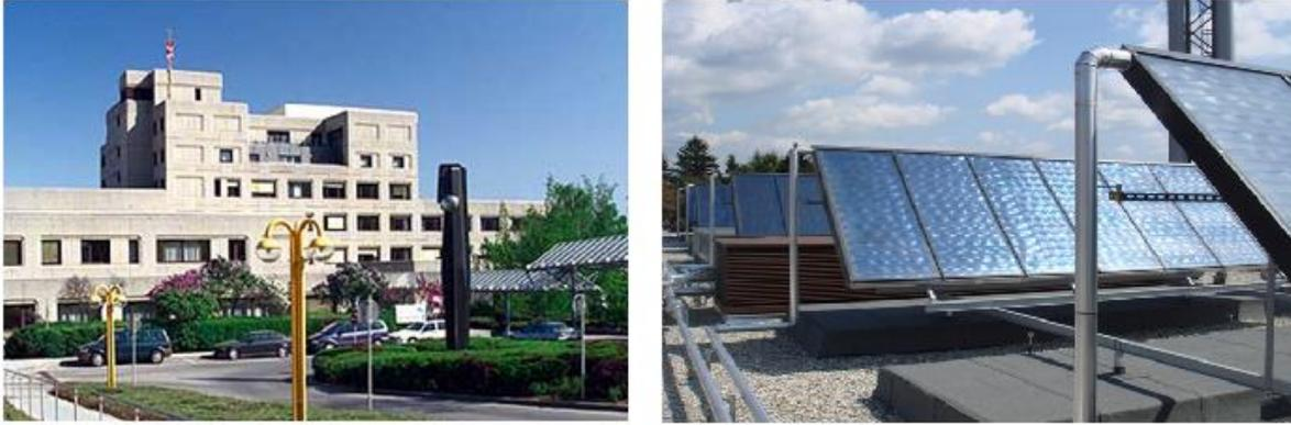
Abbildung 149: Ansicht des "Unfallkrankenhauses Graz" (links, Bildquelle: AUVA) und Ansicht des 210 m<sup>2</sup> umfassenden Kollektorfelds am Dach des Heizhauses (rechts, Bildquelle: AEE INTEC)
