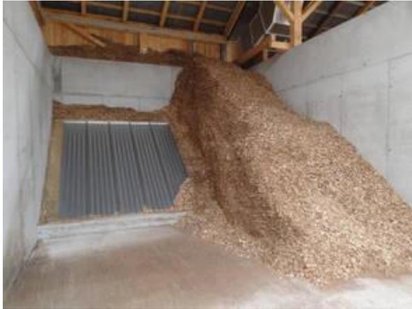
Abbildung 199: Beispielhafte Darstellung eines für das Projekt "Hackgut-trocknung Reich" installierter Schrägrost-Hackgut-trockner (Quelle: [www.cona.at](http://www.cona.at))
