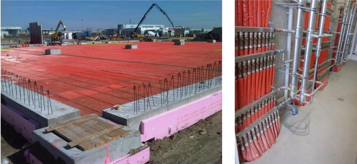
Abbildung 300: Rohrregister (rot) des Erdspeichers bei der Verlegung (links). Verteiler und Verrohrung der Rohrregister (rechts), Bildquelle: AIT
