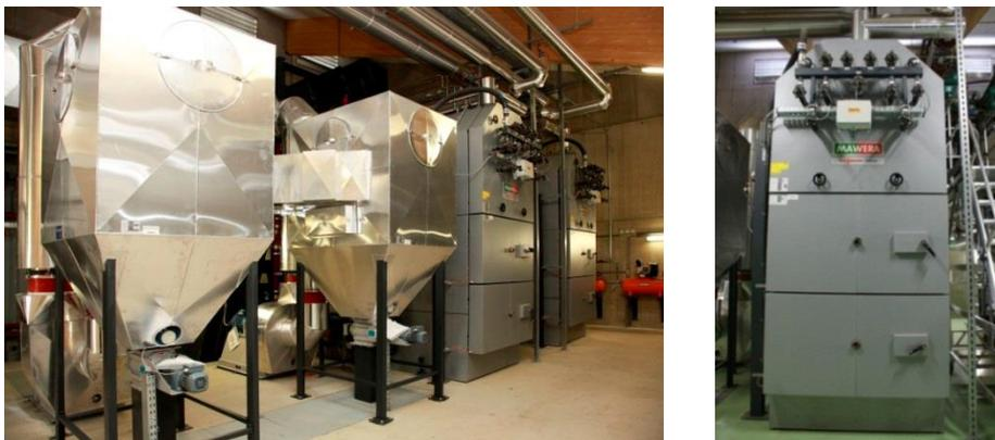
Abbildung 222: Ansicht der beiden 850 kW Biomassekessel im Heizhaus der Anlage „Nahwärme Gleisdorf - Schillerstraße“, Bildquelle: Feistritzwerke STEWEAG GmbH
