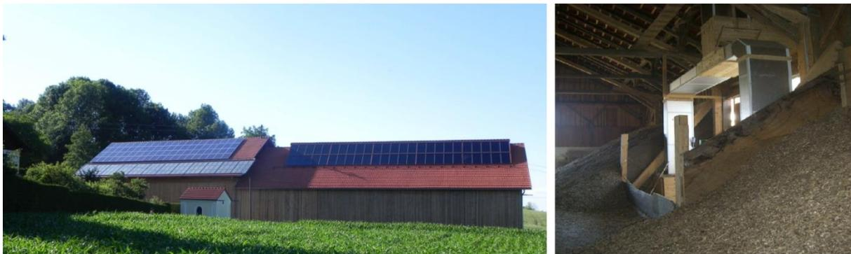
Abbildung 198: Ansicht des neu errichteten 102 m<sup>2</sup> umfassenden Kollektorfelds der Anlage „Holz Trocknung Reich“ (linkes Bild, rechte Dachhälfte) sowie des Hackgutlagers und der Trocknungsanlage (rechtes Bild), Bildquelle: Rupert Reich
