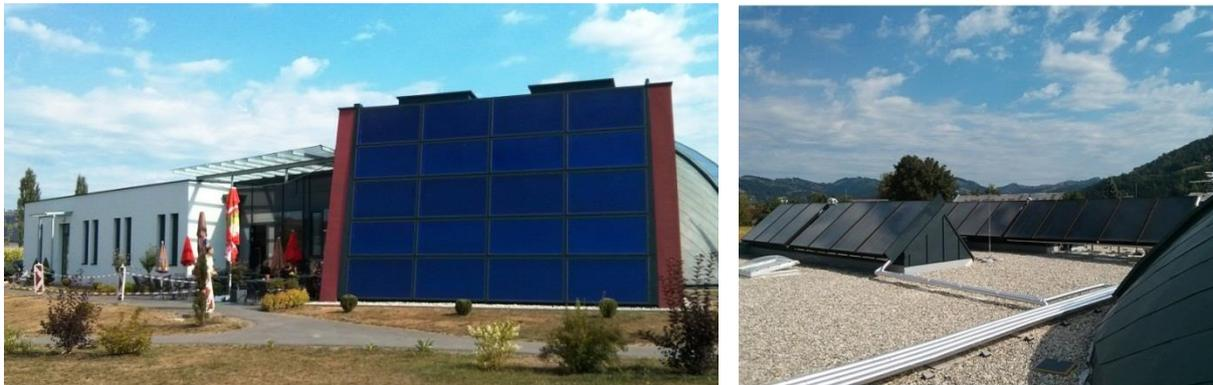
Abbildung 283: Ansicht des 50 m<sup>2</sup> großen Kollektorfeldes an der Fassade des Gemeinde-Ärzte-Zentrums (links) sowie Ausschnitt des 85 m<sup>2</sup> großen Kollektorfeldes am Dach des GÄZ (rechts), Bildquelle: AEE INTEC
