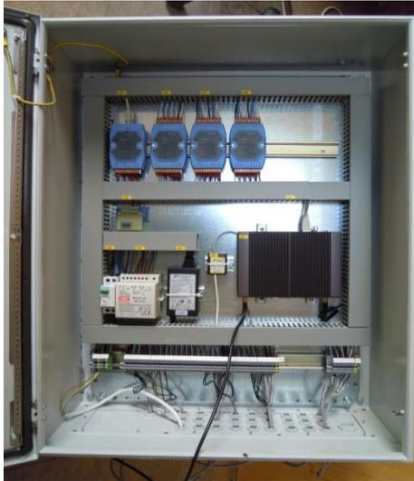
Abbildung 137: Monitoring Box der Anlage „Nahwärme Kraubath“ mit Eingangsbaugruppen (oben) und Industrie-PC (rechts), Bildquelle: AIT
