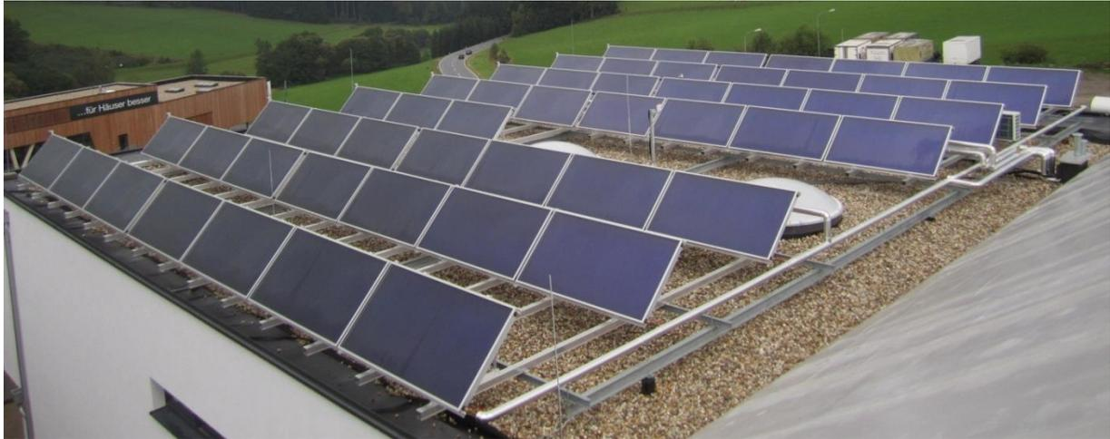
Abbildung 163: Aufgeständerte Kollektorfelder am Dach des Gebäudes „Easy Life Schütz“,
