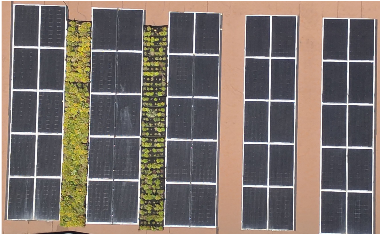
Abbildung 13: Vegetationsentwicklung und Pflanzenüberdeckung der Pflanzmodule (links bewässert, rechts ohne Bewässerung) am 07.10.2024 (Drohnenfoto: Gerold Steinbauer)
